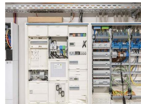
Stromspeicher (links) und Elektro-Energieverteilung (rechts) mit Energiemanagement und Smart-Home-System KNX
