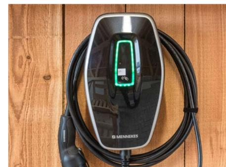
Wallbox – Elektroauto-Ladestation, über das Energiemanagement mit der PV-Anlage verbunden, um überschüssigen Solarstrom zum Laden zu nutzen
