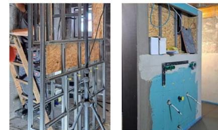
Das alte Bad mit Trennwänden aus Trockenbau wurde komplett entkernt. Danach folgte der Aufbau neuer Installationswände, in denen die Sanitär- und Elektroleitungen verlegt und die anschließend beidseitig mit stabilen OSB Platten und Rigips Feuchtraumplatten beplankt wurden. Die vertiefte Aussparung oberhalb des Waschbeckens ist für den Spiegelschrank vorgesehen.
