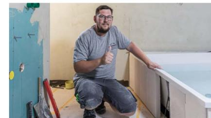
Alexander Mizel von Muntermann Bau GmbH beim Verkleiden der neuen Badewanne mit Wandfliesen. Bis zum finalen Einbau aller Sanitärobjekte wurde ein neuer Estrich verlegt. Ein Teil der Wände erhielt Fliesen, der andere eine glatte Putzoberfläche. Der Fußboden wurde komplett gefliest und der Duschboden rutschhemmend ausgebildet.
